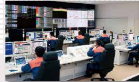
消防システム
