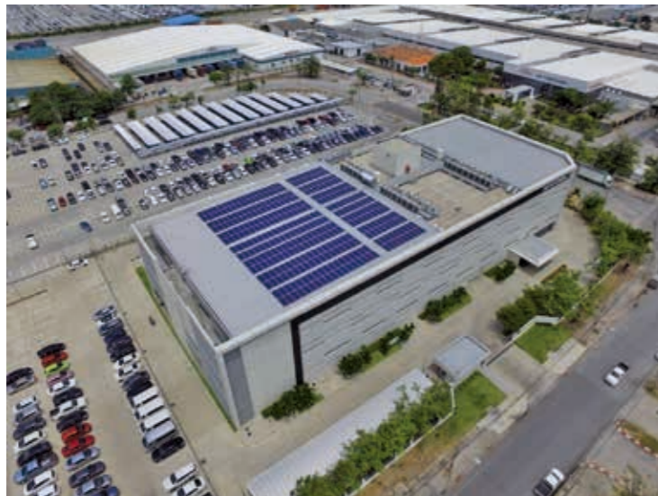
Fujitsu General Air Conditioning R&D (Thailand) Co.,Ltd.の屋上に新設した太陽光パネル
