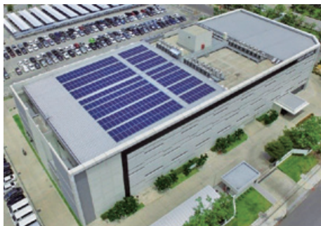
タイのR&Dセンター 太陽光パネルを設置し自家消費を行います。
