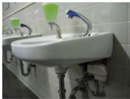
本社の改修した水栓
