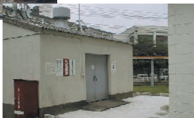
漏液浸透防止対策(本社地区)
