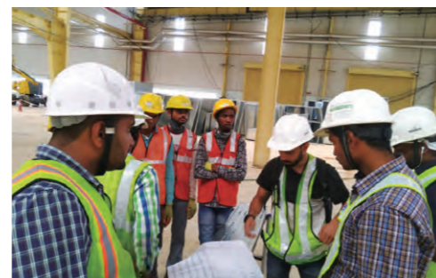
ダクト施工の様子
