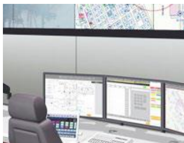
消防システム
