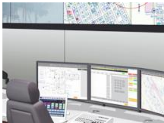
消防システム
