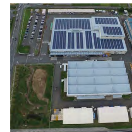
▲浜松事業所 上：建物屋上に太陽光発電システムを設置 左下：ビオトープ
