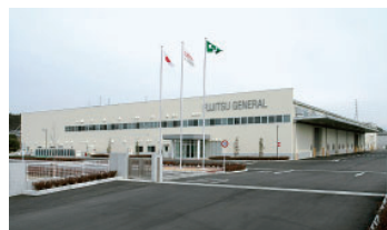
リサイクル新工場の外観 (子会社「株式会社富士エコサイクル」)
