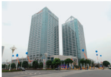
VRF(室外機496台、室内機2,142台)を納入した常州世界貿易センタービル(中国)
